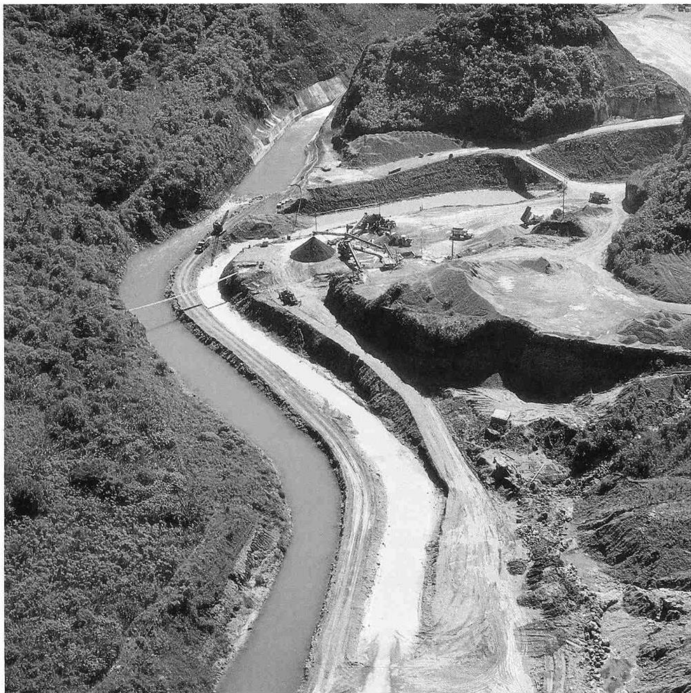
Obras en el canal de descarga de la hidroeléctrica Chixoy, en Guatemala; página opuesta: gasoducto Neuba II, en Argentina.
